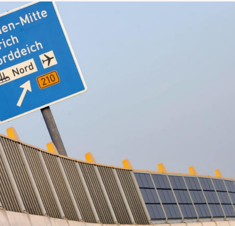
Schallschutz mit Fotovoltaik entlang der A 31 in Emden
